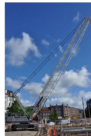
GITTERBOM KRANER PÅ BÆLTE
